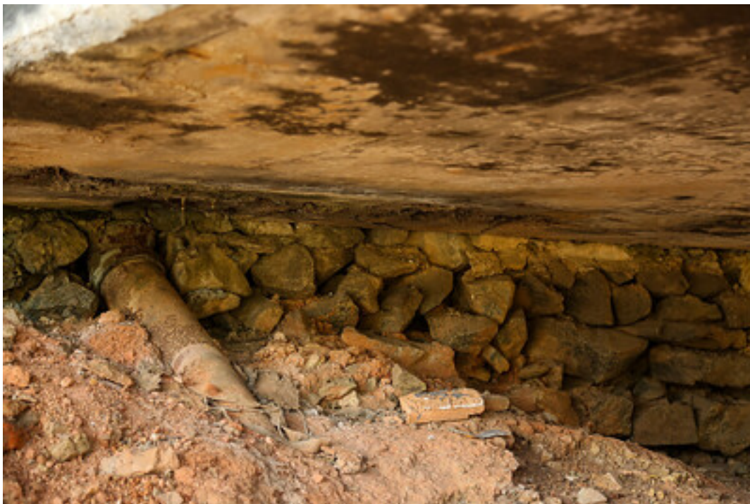
Presença de corrosão na estrutura
