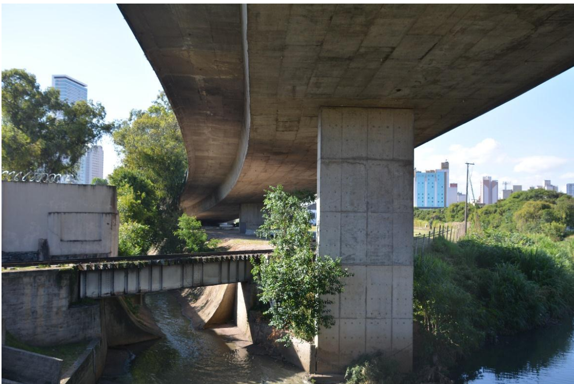
Trecho em curva, lado centro. Nota-se a presença de mancha de fuligem na região sobre a linha férrea decorrente do tráfego de trens
