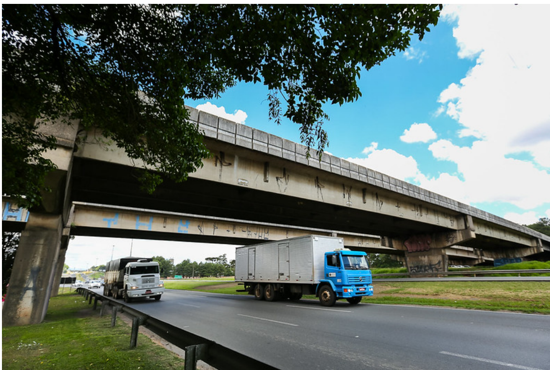
Viaduto que liga o contorno norte com o com o contorno sul.
